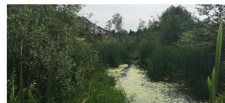
Constructed Headwater Drainage Feature with Riparian Planting Dispositif de drainage des eaux d'amont aménagé avec établissement d'une bande riveraine
