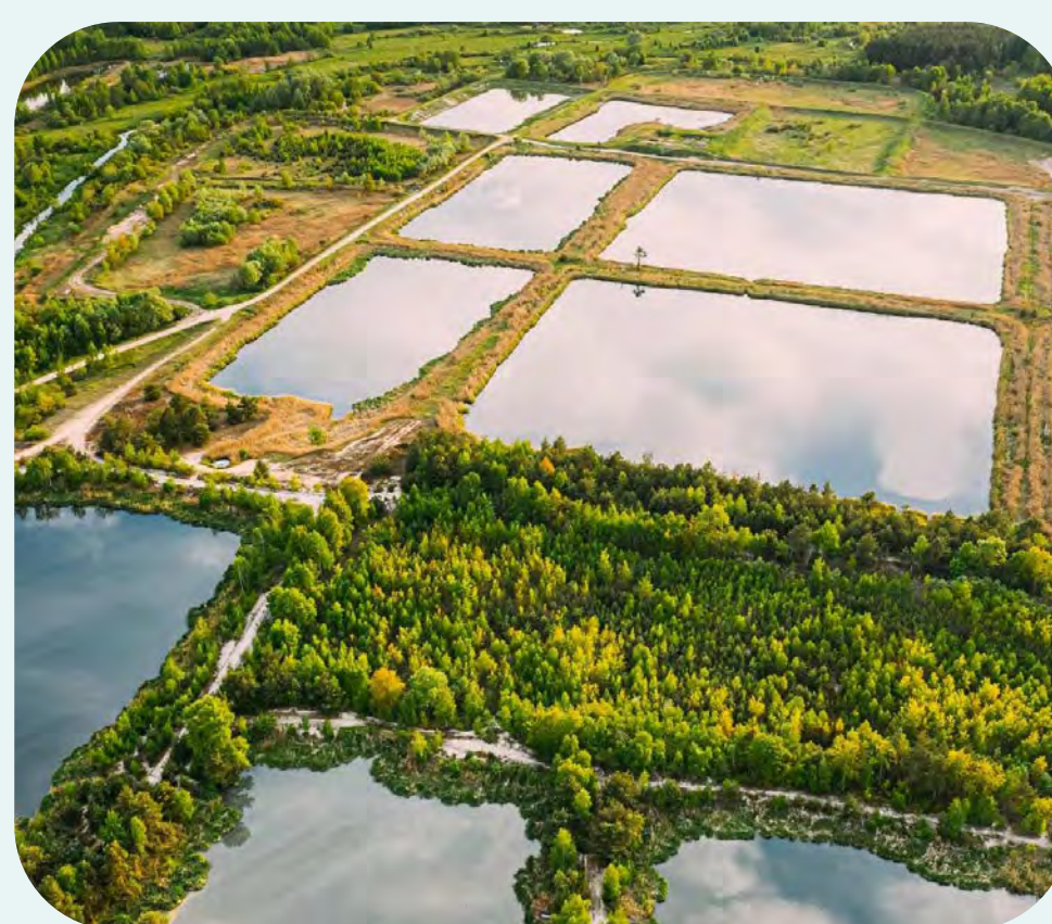
bassins d'eaux de ruissellement
